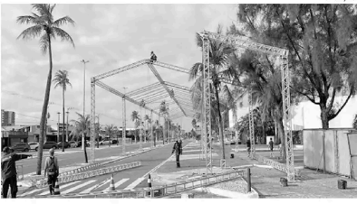
Equipamentos e estruturas, dão o início à montagem do Camarote Aju
